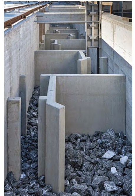
Eine der beiden Fischaufstiegsanlagen am KW Dietikon (Foto: EKZ).
