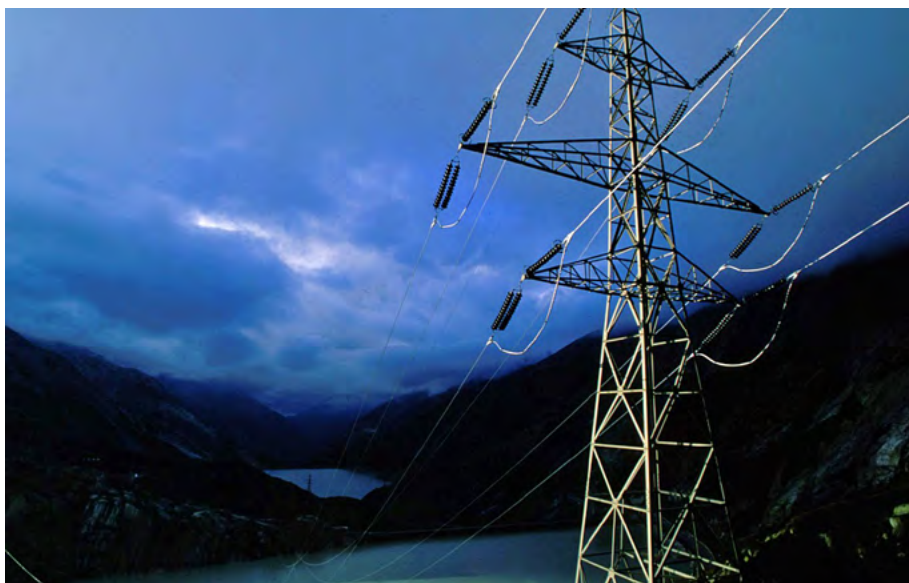
Transitleitung über den Grimselpass (KWO, Foto: Robert Bösch).
