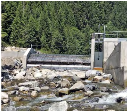
Kraftwerk Schanielabach im Prättigau (Foto: Gemeinde Luzein).
